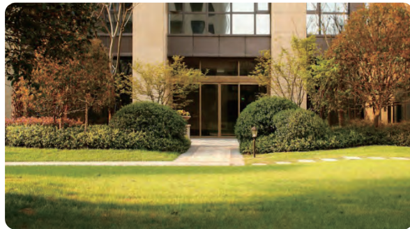
業主採用智慧識別進出大門
